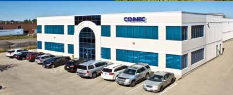
CONEC Canada, Brampton
